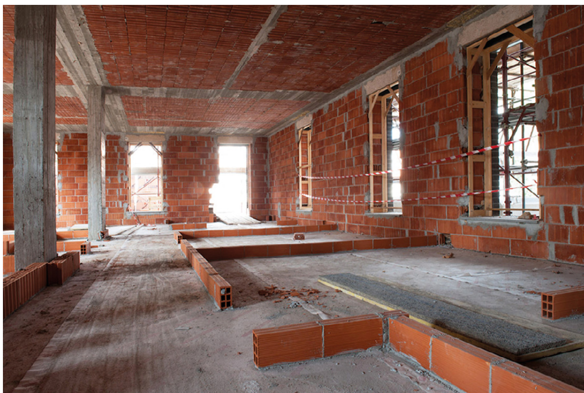
Dettagli di cantiere.
